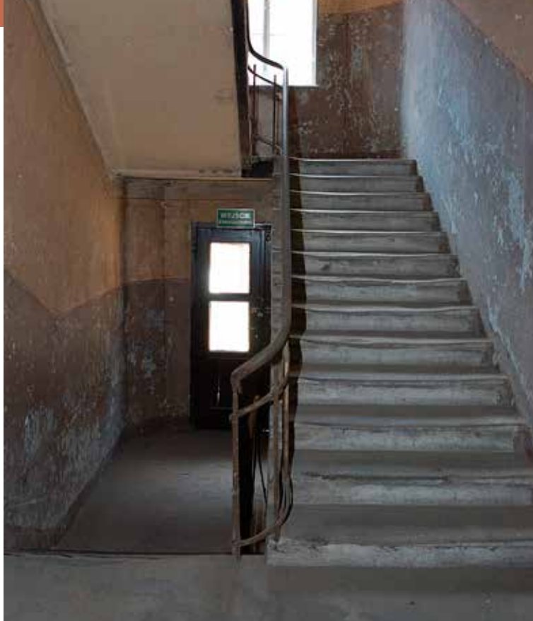
52-53. Blok 3. Klatka schodowa. Stan przed pracami konserwatorskimi.
