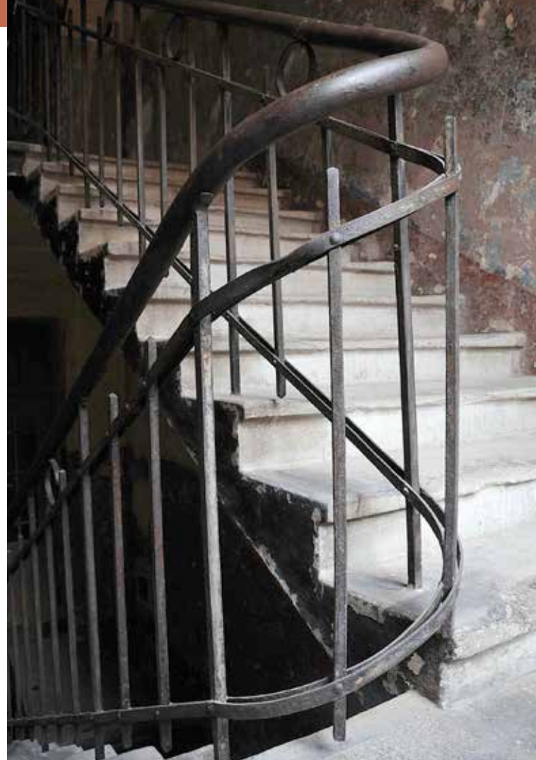
67. Blok 3. Bariierka klatki schodowej. Stan zachowania po pracach konserwatorskich.
