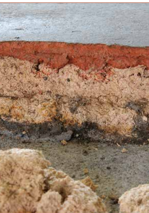
50. Blok 2. Przekrój ksyloplity. Stan w trakcie prac przy uszkodzonym fragmencie posadzki.
