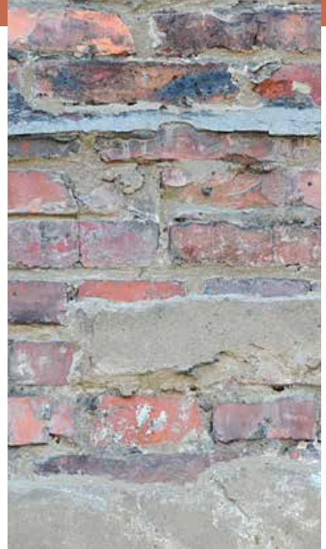
24. Blok 2. Elewacja północno-wschodnia. Charakterystyczny niestaranny sposób opracowania lica z widocznymi pozostałościami tynku po nieistniejącej już łaźni obozowej. Stan po pracach konserwatorskich.
