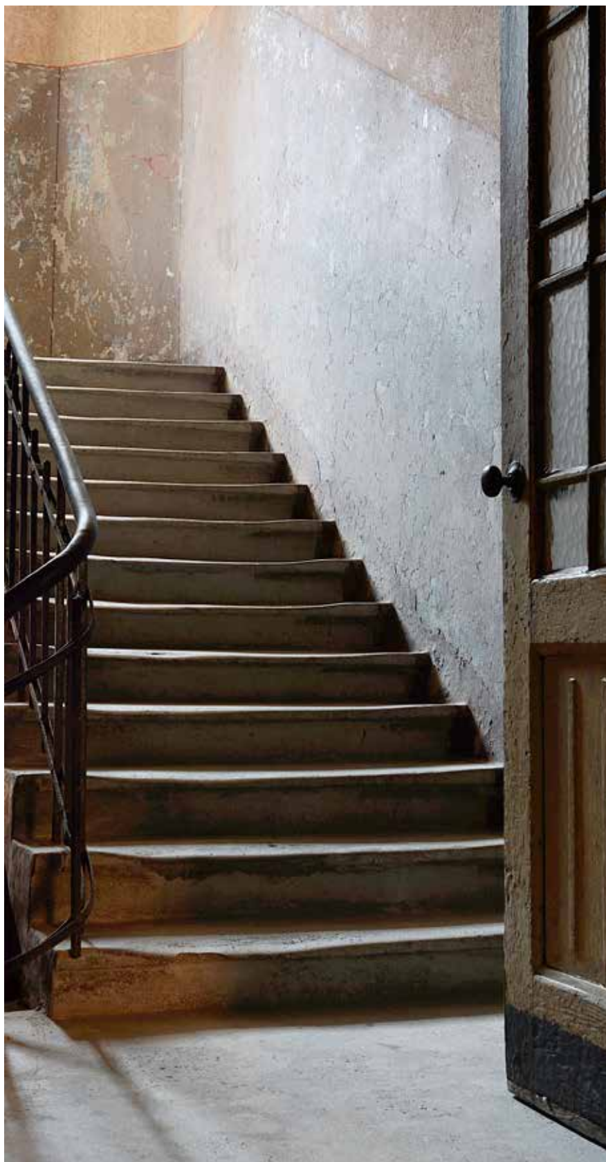
31. Blok 3. Klatka schodowa. Stan po pracach konserwatorskich.
