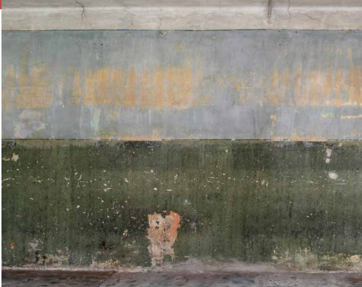
11. Blok 2. Izba więźniarska z uszkodzeniami warstw malarskich w miejscach, gdzie do ścian przylegały prycze więźniów.
