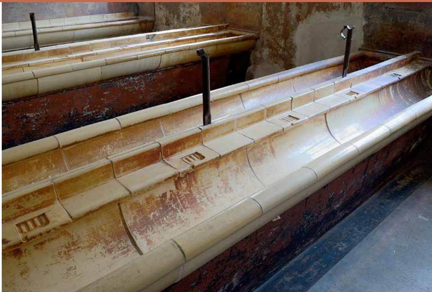
58. Blok 2. Umywalnia. Stan zachowania koryt ceramicznych po pracach konserwatorskich.
