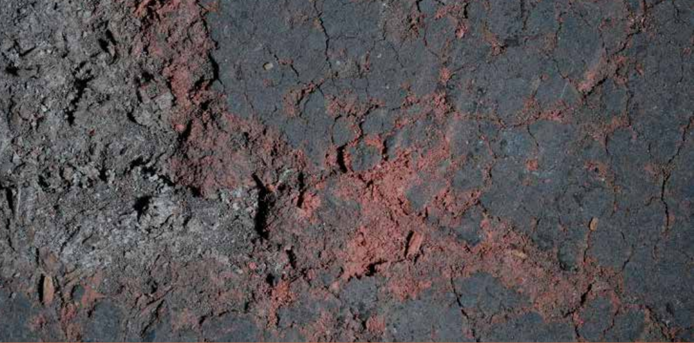
49. Blok 2. Stan zachowania ksyloplitowej posadzki przed pracami konserwatorskimi.
