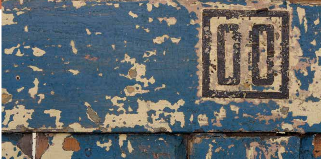
29-30. Blok 2. Drzwi do izby więźniarskiej. Stan po pracach konserwatorskich.
