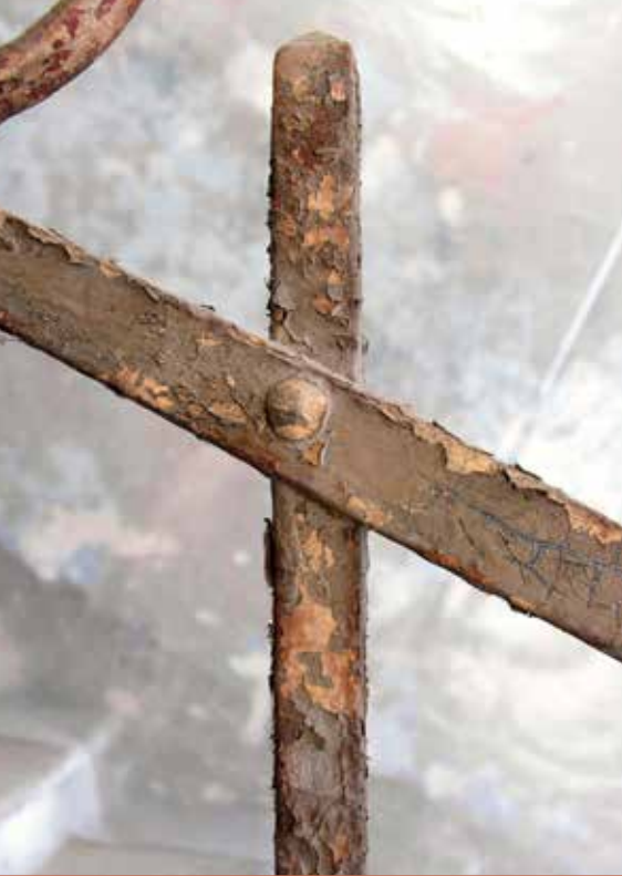
65-66. Blok 3. Klatka schodowa. Stan zachowania warstw malarskich na metalowych elementach balustrady przed i po pracach konserwatorskich.
