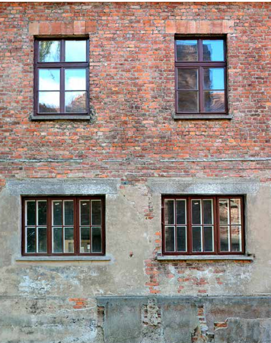
24. Blok 2. Elewacja północno-wschodnia. Charakterystyczny niestaranny sposób opracowania lica z widocznymi pozostałościami tynku po nieistniejącej już łaźni obozowej. Stan po pracach konserwatorskich.
